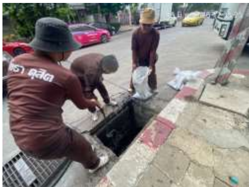
รูปที่ 33 สำนักงานเขตดุสิตมาชุดลอกตะกอนดินทรายที่อาจตกค้างในท่อระบายน้ำ
