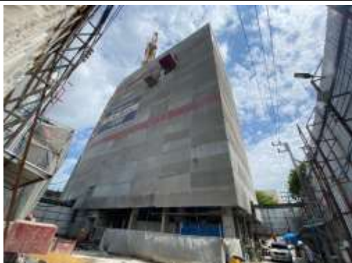
รูปที่ 14 ติดตั้งตาข่ายกันฝุ่น (Mesh Sheet) ปิดคลุมด้านนอกโดยรอบโครงสร้างอาคาร
