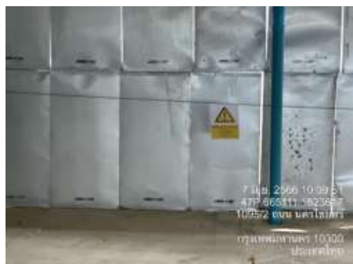
รูปที่ 23 ติดตั้งแผ่นกันเสียง Bloxteg ล้อมรอบอาคารชั้นที่กำลังก่อสร้าง
