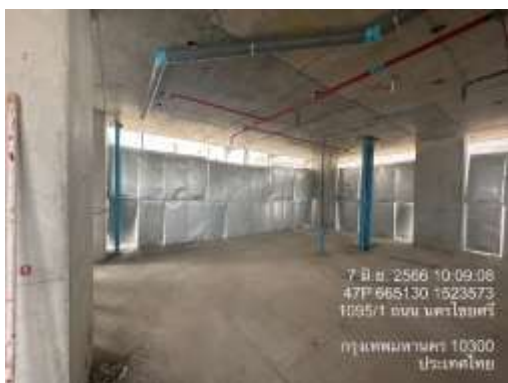
รูปที่ 23 ติดตั้งแผ่นกันเสียง Bloxteg ล้อมรอบอาคารชั้นที่กำลังก่อสร้าง
