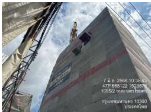
รูปที่ 14 ติดตั้งตาข่ายกันฝุ่น (Mesh Sheet) ปิดคลุมด้านนอกโดยรอบโครงสร้างอาคาร
